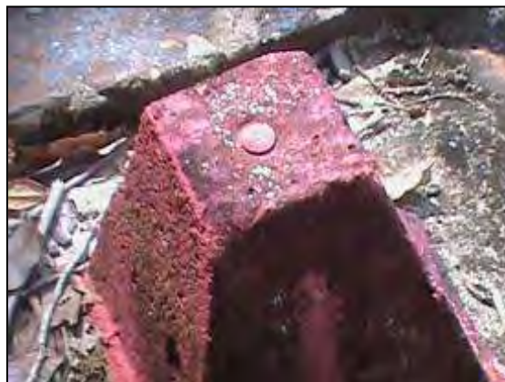
Marco topográfico de delimitação das áreas do canteiro de obras ao lado do traçado do acesso provisório. (Topo).
